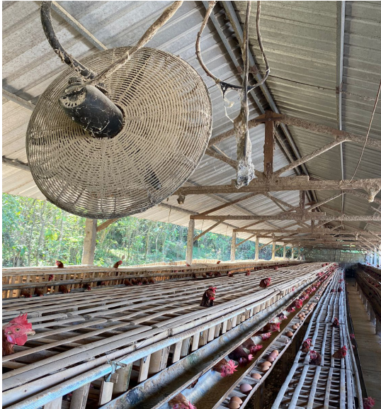
Gambar 15. Kipas dorong di kandang ayam layer untuk membantu sirkulasi udara lebih baik (Dok. Penulis, 2023)
