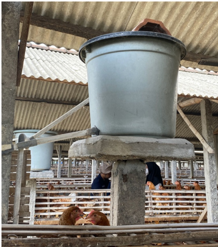
Gambar 12. Fasilitas instalasi air minum di kandang ayam petelur (Dok. Penulis, 2023).
