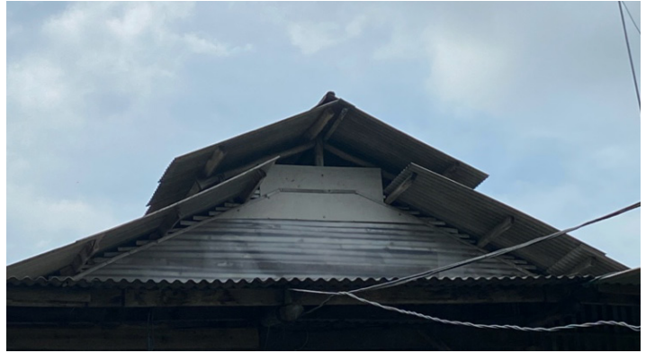
Gambar 5. Bentuk atap kandang ayam broiler jenis atap monitor (Dok. Penulis)
