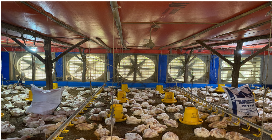
Gambar 7. Kipas exhaust pada kandang ayam broiler closed house (Dok. Penulis, 2023)
