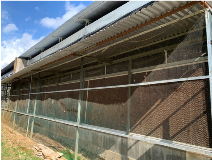
Gambar 21. Cooling Pad pada kandang ayam broiler (Dok. Penulis, 2023)
